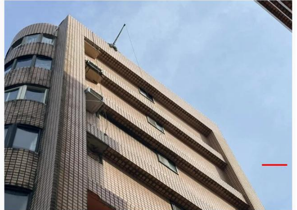
新北市三芝區樂全街一處社區大樓，今天下午3時51分左右發生墜樓工安意外，1名53歲工人在大樓外牆垂降修補冷氣孔，疑因繩索斷裂自5樓墜地，傷勢嚴重無呼吸心跳由救護車緊急送醫，急救後宣告不治。記者林昭彰／翻攝
